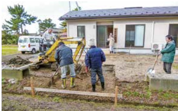
↑舗装工事の様子
