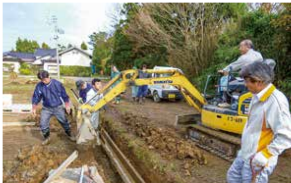
↑舗装工事の様子
